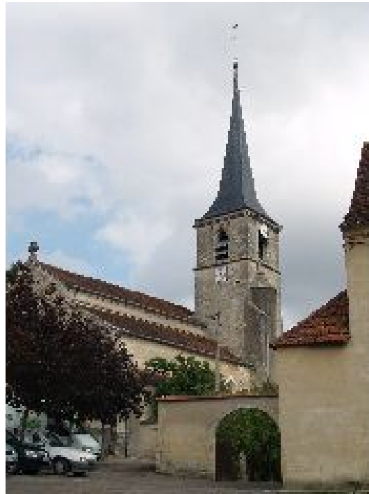
Photo : Église paroissiale d'Ancy-le-Franc Cliché R. T.
