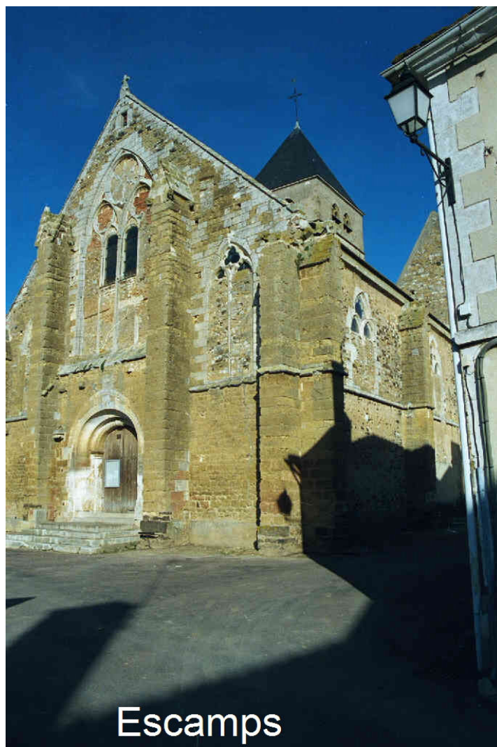
Église de Escamps Cliché RT
